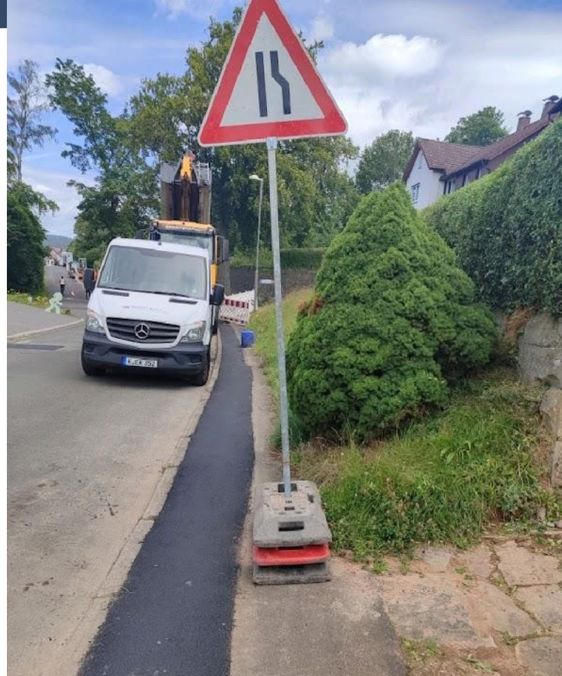
Feinschicht ein paar Tagen später eingebaut
