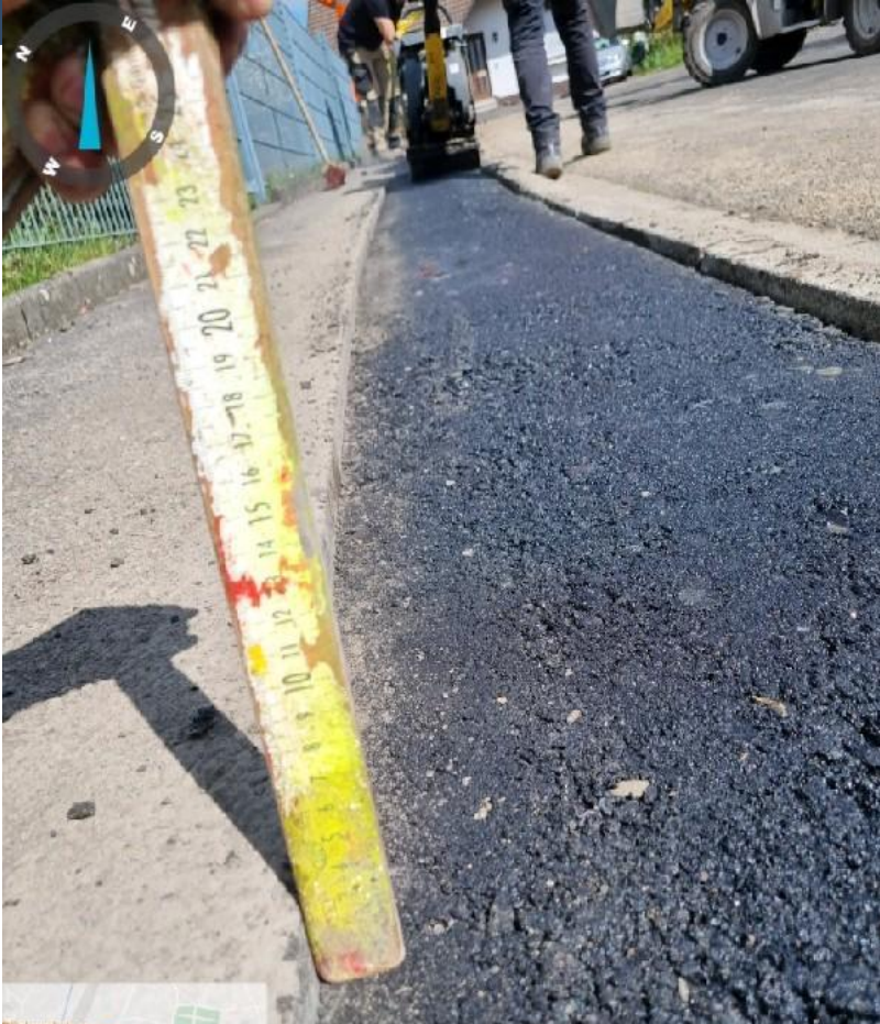
Tragschicht am selben Tag eingebaut
